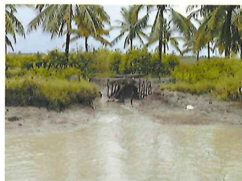
この水門が「天然囲い込み方式」の要となっている。
